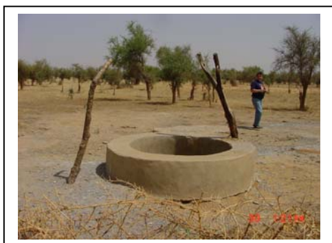
Puits dans le désert du Gourma
